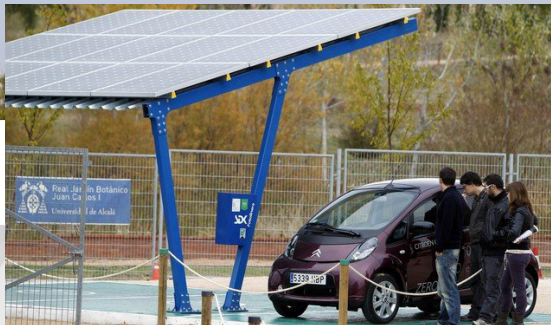
Lieu : Espagne Taille du système : 2,85kW Type de construction : Abri de parking PV Fin des travaux : 2011 Installateur : Sendekia
