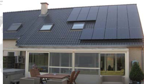
Lieu : Divers, Belgique Type de construction : Intégration simplifiée Fin des travaux : 2011 Installateur : Artinis
